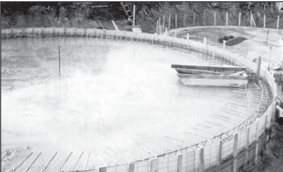
Ein Spanngurt, um die Schalungen gelegt und während des Betonierens gestrafft, stützt die Schalung nach außen
